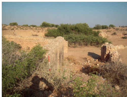
Fig. n° 16 : Couloir de jonction entre bassins [éch. = 1 m] (ph. N. Belmabrouk).
