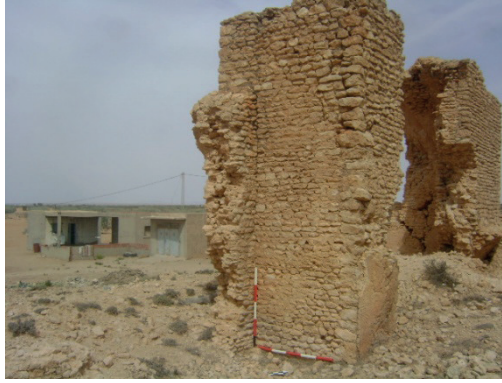
Fig. n° 3 : Structure indéterminée [éch. = 1 m] (ph. N. Belmabrouk).
