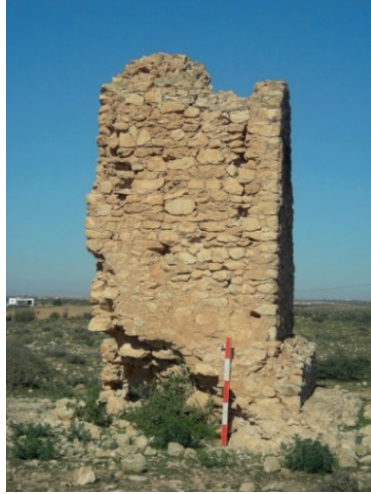
Fig. n° 10 : Mausolée-tour Qsar Mongoub [éch. = 1 m] (ph. CNISAMH).
