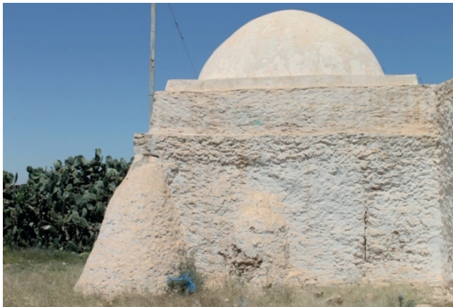
Fig. 13 : Coupole de l'extérieur et contrefort d'angle.
