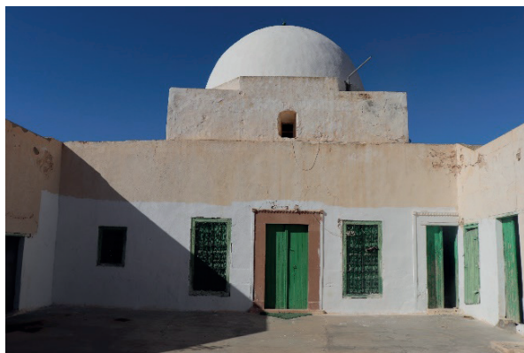
الصورة عدد 5: الواجهة الخارجية لغرفة الضريح
