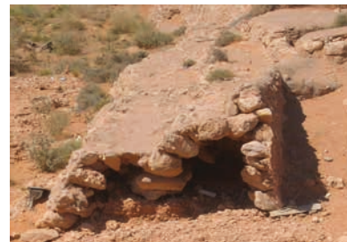
Digue et déversoir d'eaux pluviales partiellement effondré
