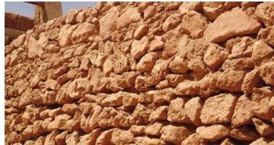
Pierres minutieusement superposées sans lien d'attache
