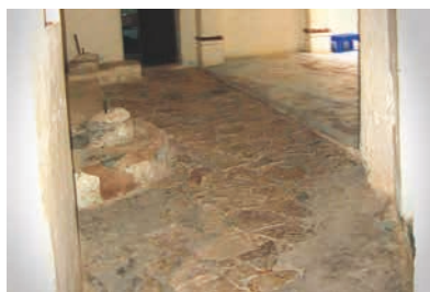
Pavage de la maison avec des pierres multiFormes
