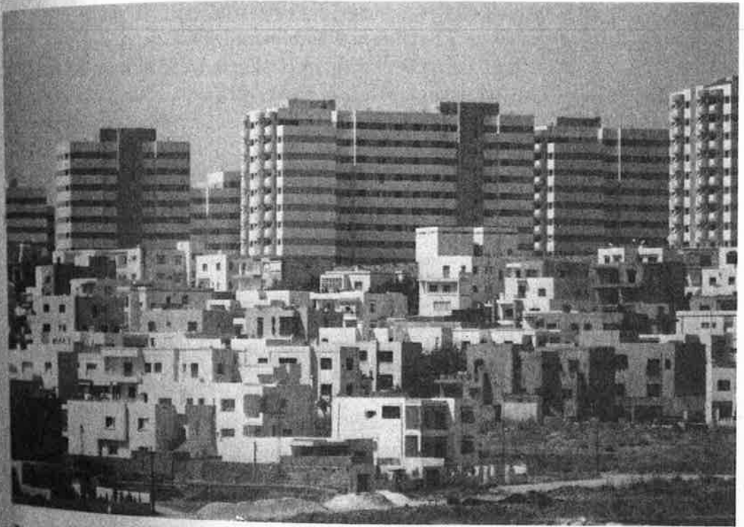
Tunis-El Menzah : une véritable ceinture de béton s'érige aujourd'hui à la périphérie nord-est de Tunis, destinée à l'absorption d'un surplus démographique citadin : villas individuelles et "buildings" de 8, 10 et 12 étages pour une bourgeoisie moyenne relativement aisée ainsi que pour touristes arabes du Golfe ("les pétros") qui souvent préfèrent l'habitation individuelle à l'hôtel. Ce qui "impressionne" dans cette zone : la laideur architecturale évidente et la mauvaise qualité des matériaux de construction utilisés.
