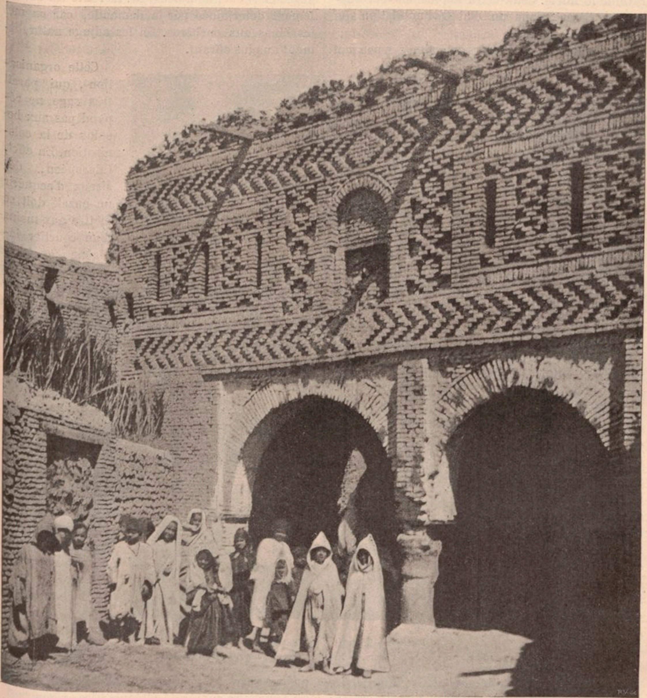
Fig. 49. — Maison à Tozeur.
