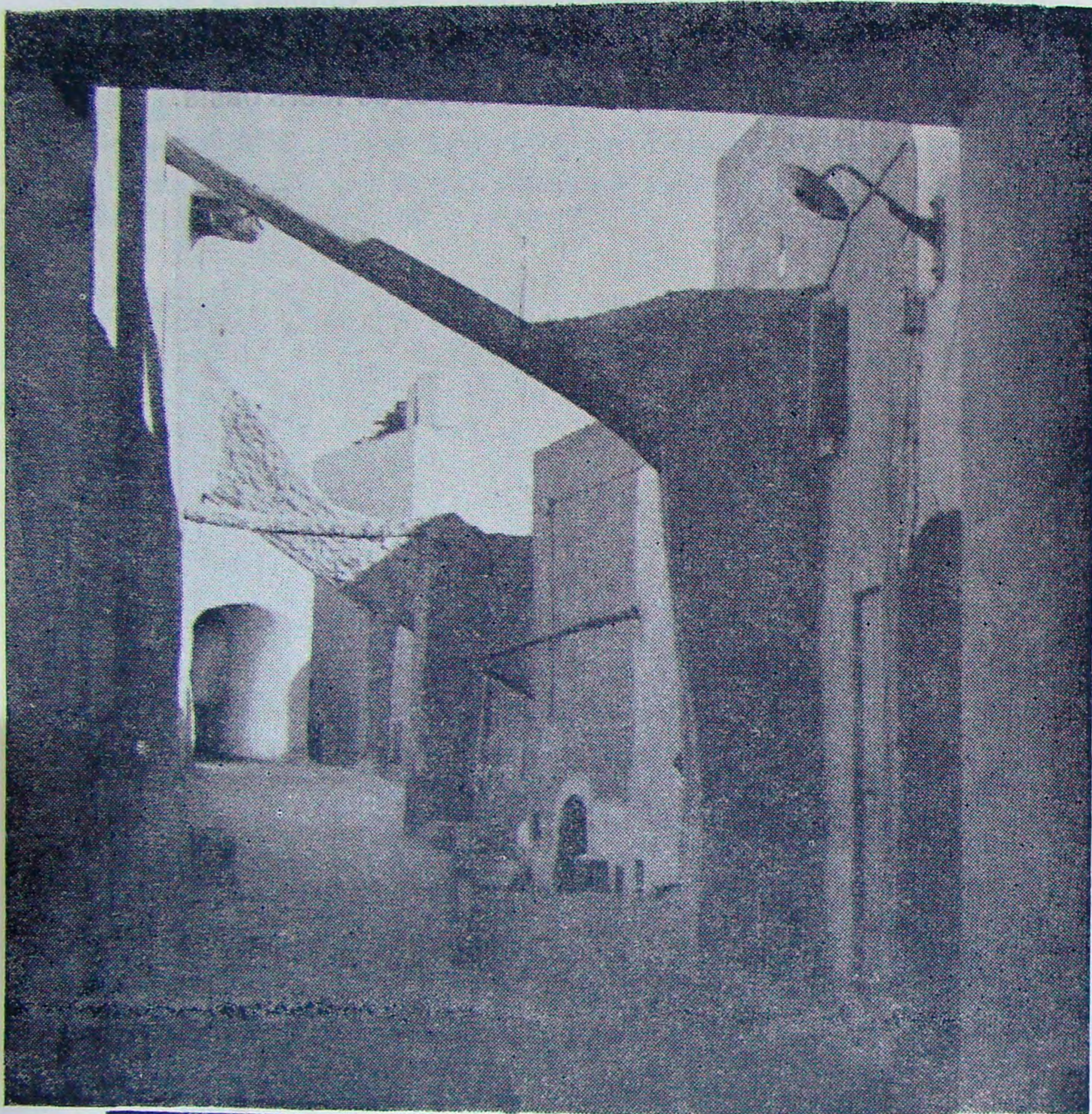
Anciennes Rues de Ghardaia les murs soutenus par des Poutres (1053 l'Hégire)
