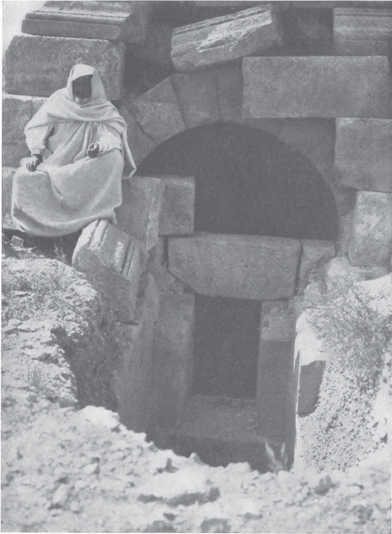
Fig. 2 - Gusr El Berber - Ingresso alla cripta
