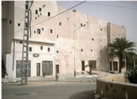
الواجهة بعد الترميم
