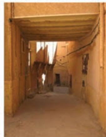
الأرضية قبل عملية الترميم
