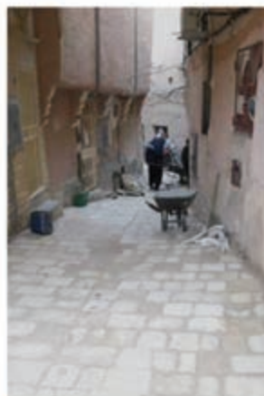
الأرضية بعد عملية الترميم
