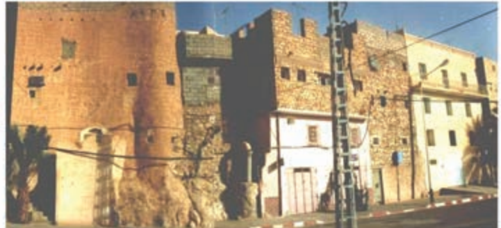
واجهة بنورة قبل عملية الترميم
