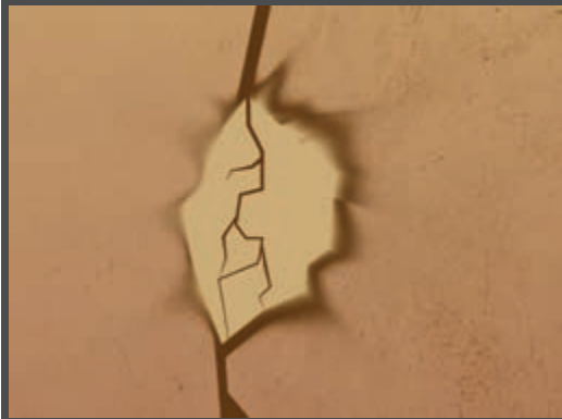
إستمرار اتساع الشقوق و انكسار صفائح الجبس
