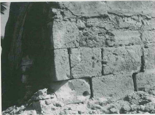
رسم 35058 تقنية التغليف بالحجارة المهدمة
