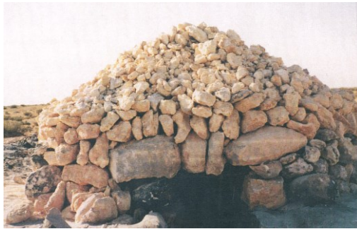
بناء فرن الجبس {الكوشة}
