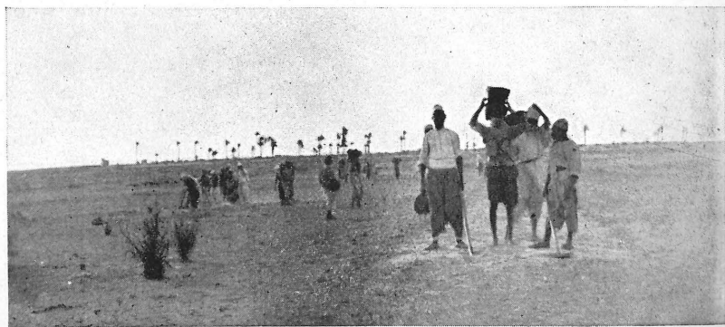
Travaux de réfection sur la route
