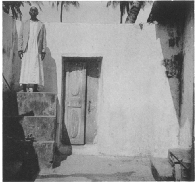
FIG. 4.—PANGANI, MASJID MWANA SUKALI, STAIRCASE MINARET.
