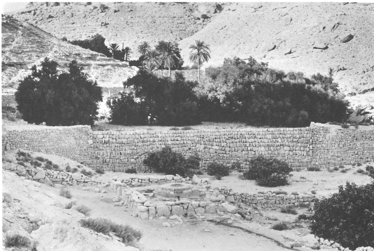
Fig. 57. — Barrage de retenue de la terre et des eaux de ruissellement.
