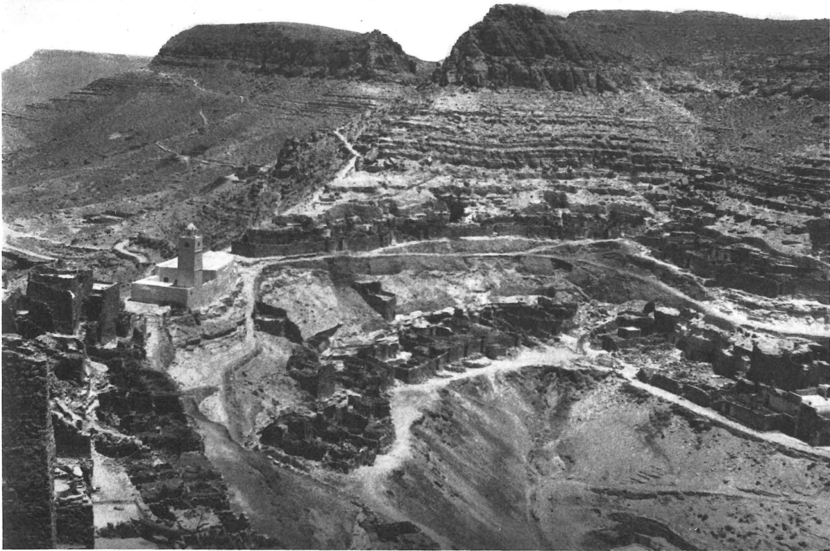
Fig. 4. — Chenini. Vue d'ensemble.
