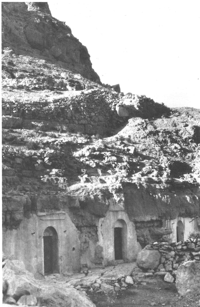
Fig. 75. — Une demeure troglodytique «latérale» (Douiret). En avant des trois portes, la cour. Les chambres s'enfoncent sous la montagne.
