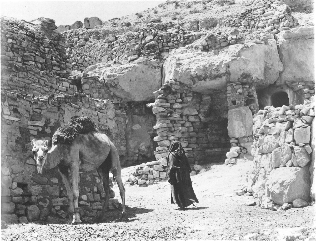
Fig. 17. — Anciennes grottes de refuge, en avant du "Ksar Kedim", réaménagées en grottes d'habitation.
