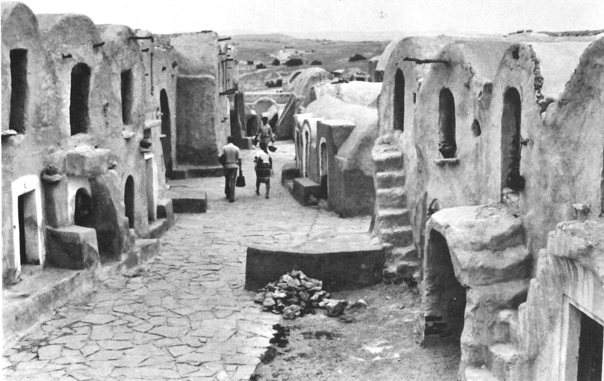
Fig. 101. – Ksar Haddada ou un tourisme d'expression locale. Les ghorfas du "ksar" ont été transformées en chambres d'hôtel.
