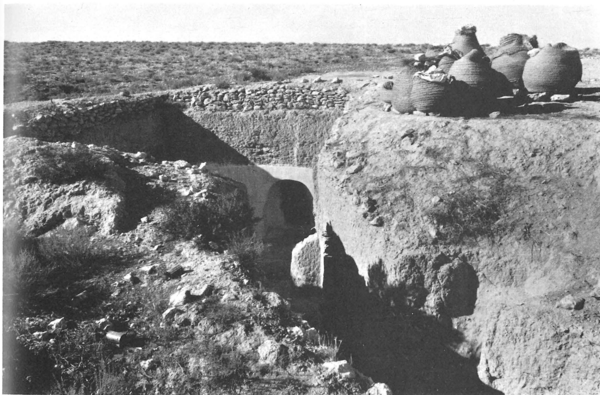
Fig. 76. — Une demeure semi-troglodytique avec couloir d'accès non couvert (région des Haouaia, Beni Kheddache).
