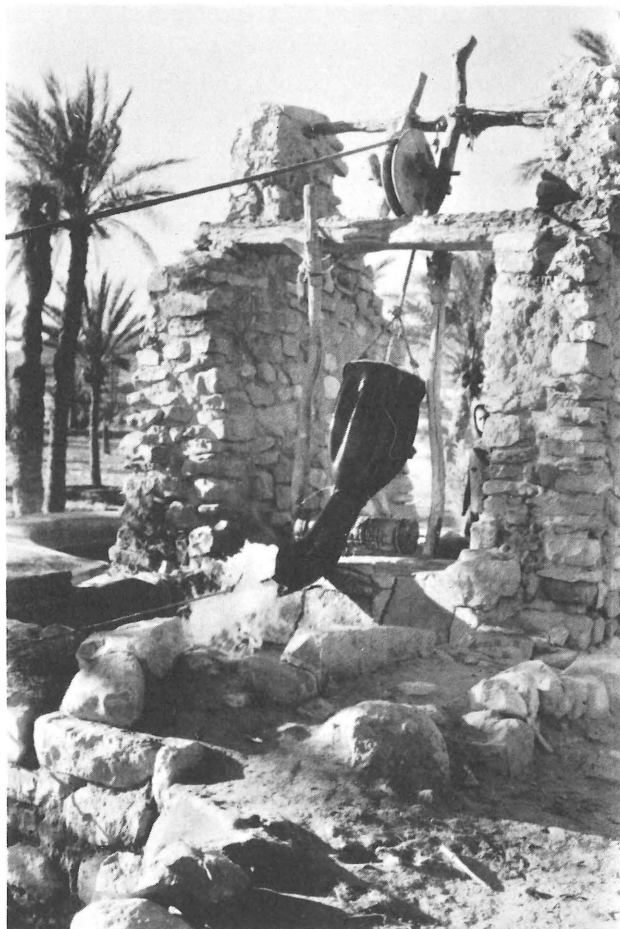
Fig. 55. — Mode de puisage. L'eau est ramenée du puits à l'aide d'une poche en cuir le dalou .
