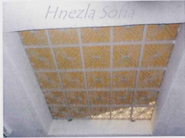
الصورة رقم 6: الفتحة في سقف المنزل التي تميز المنازل المزابية. صورة التقطناها في أحد المنازل ببني اسفن يوم 2012/08/30.
