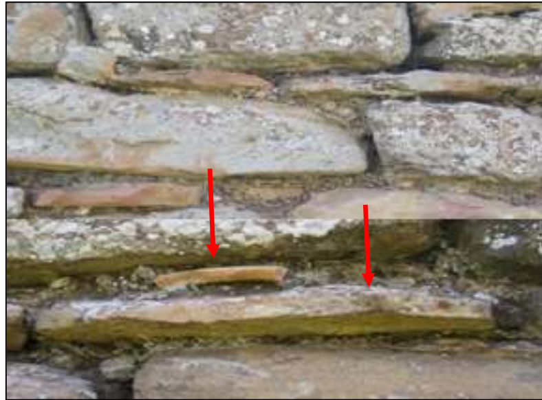
لوحة رقم (34): تقنية تسوية السافات -من إعداد الطالبة-
