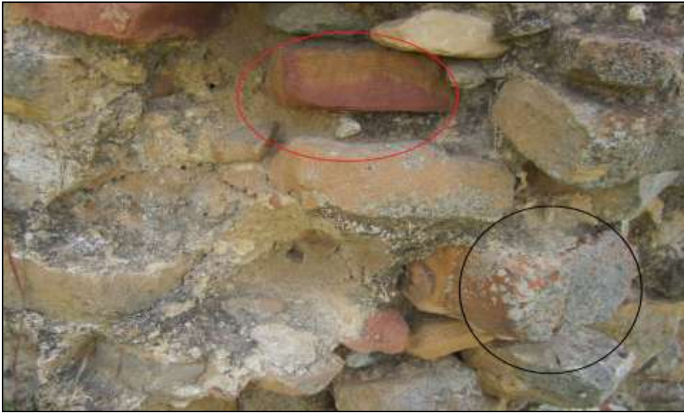
لوحة رقم (30): أنواع الحجارة في نواة الجدارية -من إعداد الطالبة-
